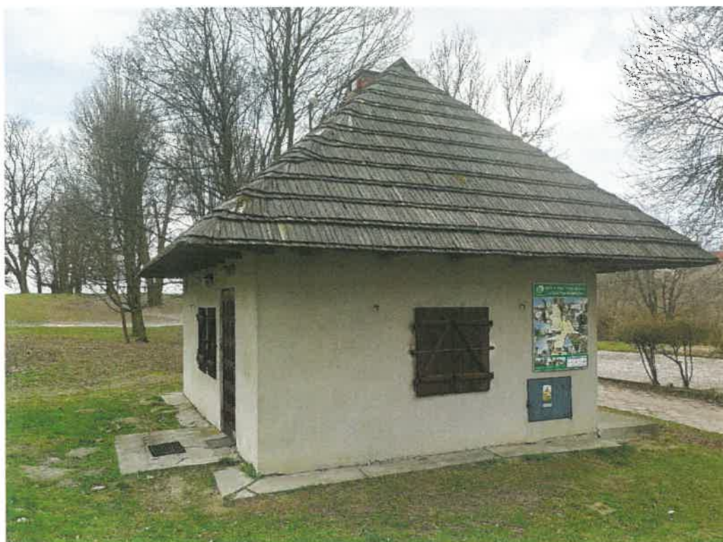
FOT. 38. Widok elewacji budynku
