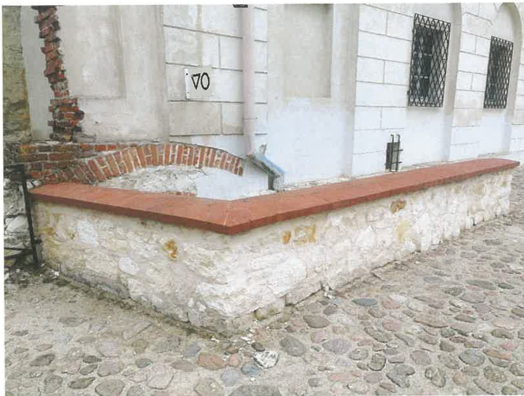
FOT. 26. Murek przeznaczony do fugowania
