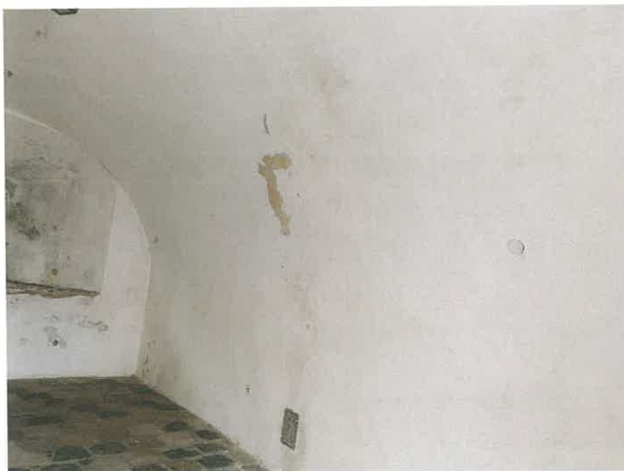
FOT. 28. Uszkodzony tynk
