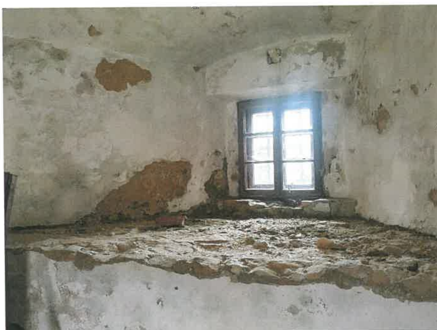
FOT. 28. Uszkodzony tynk
