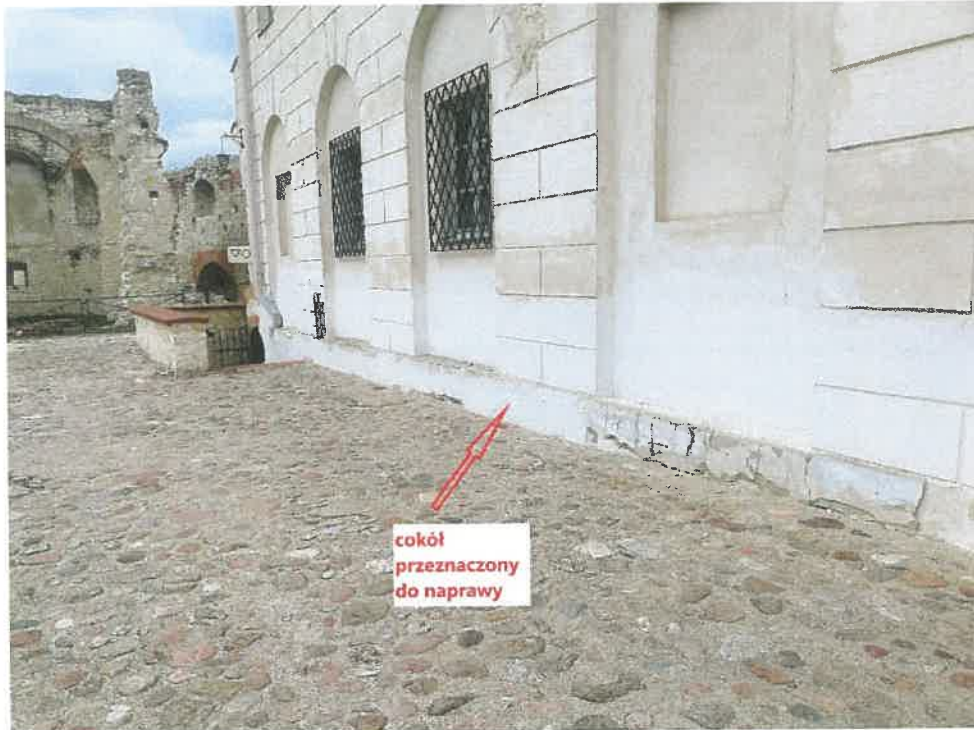
FOT. 22. Cokół przeznaczony do naprawy
