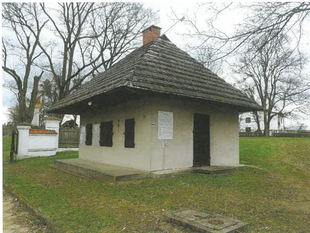
FOT. 37. Widok elewacji budynku
