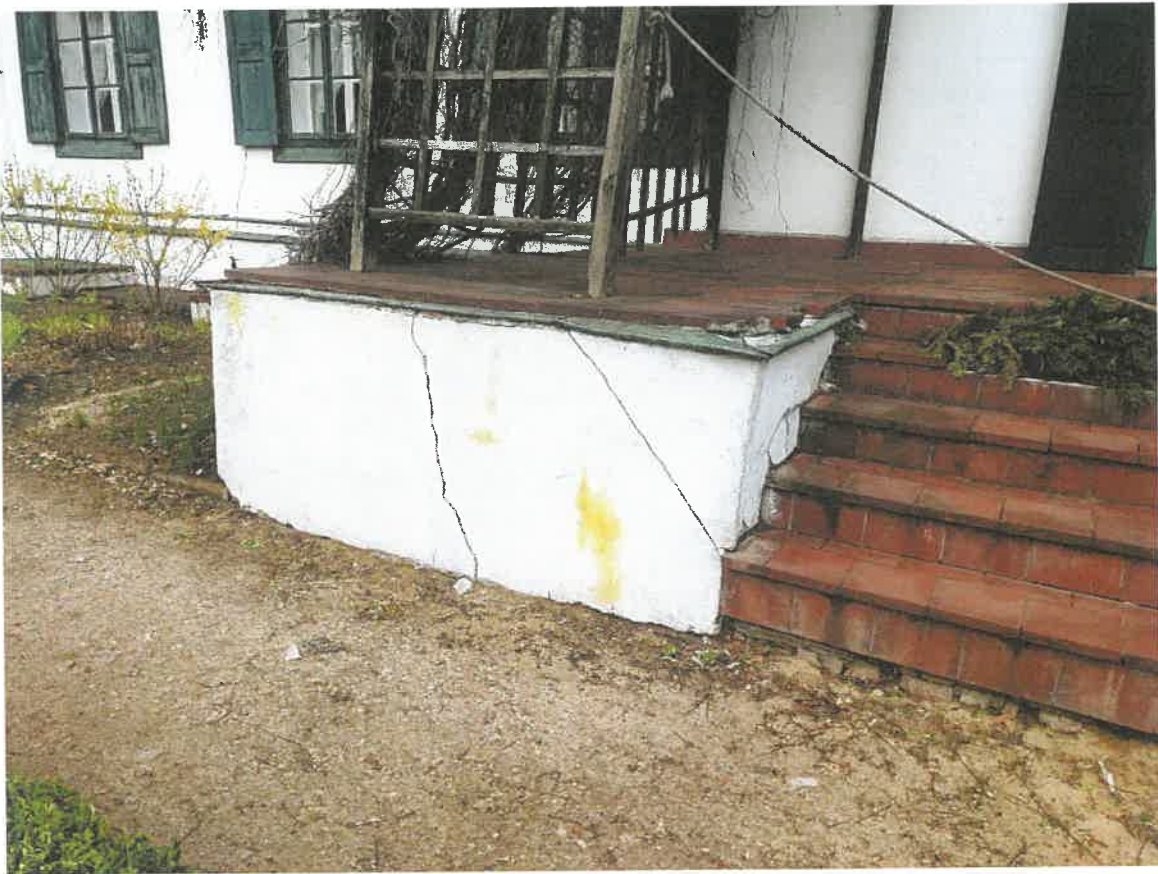
FOT. 8. Spękany tynku ścian tarasu oraz zniszczone obróbki blacharskie
