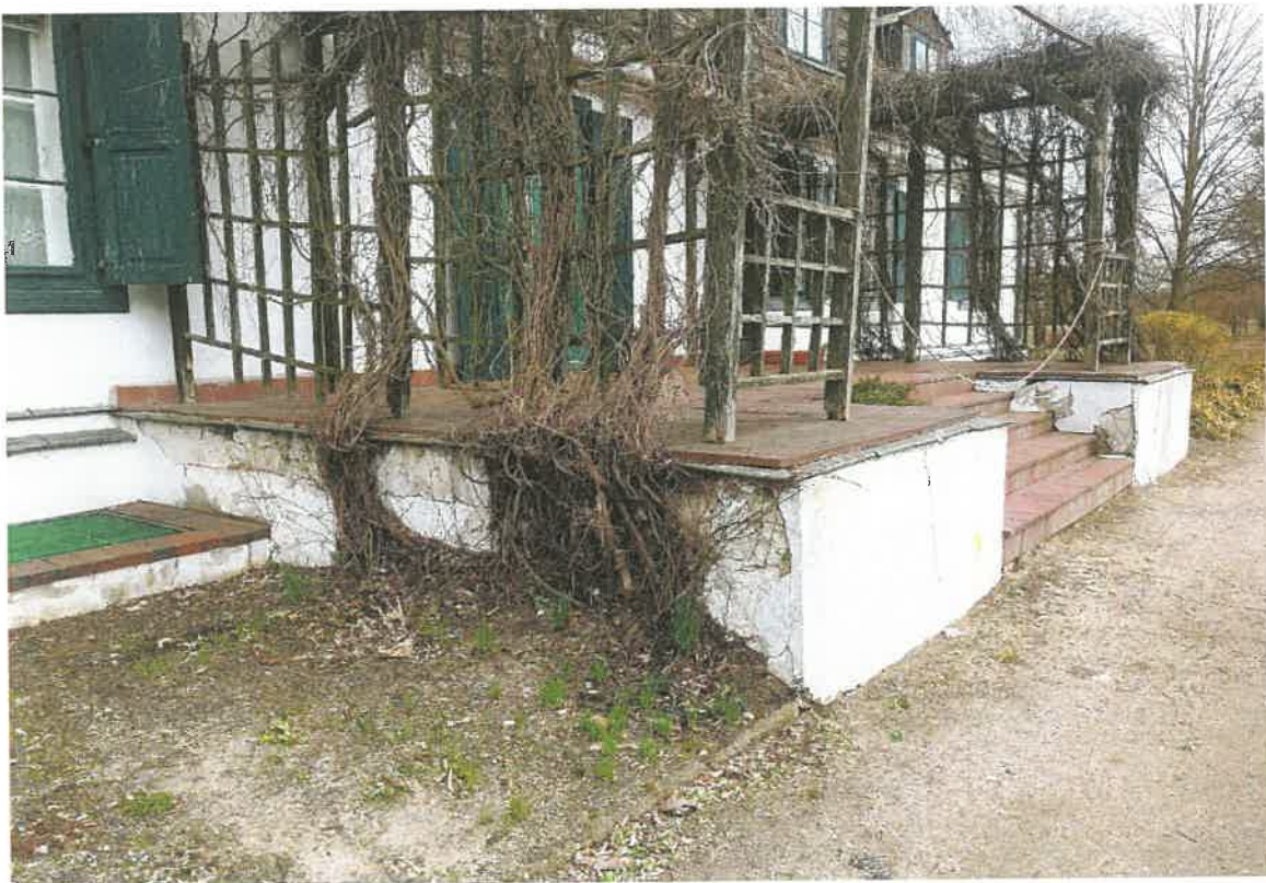
FOT. 8. Spękany tynku ścian tarasu oraz zniszczone obróbki blacharskie
