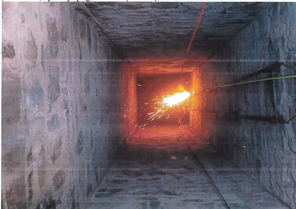
Fot. 32 Prace demontażowe utrudniała konieczność bieżącej wentylacji mechanicznej.
