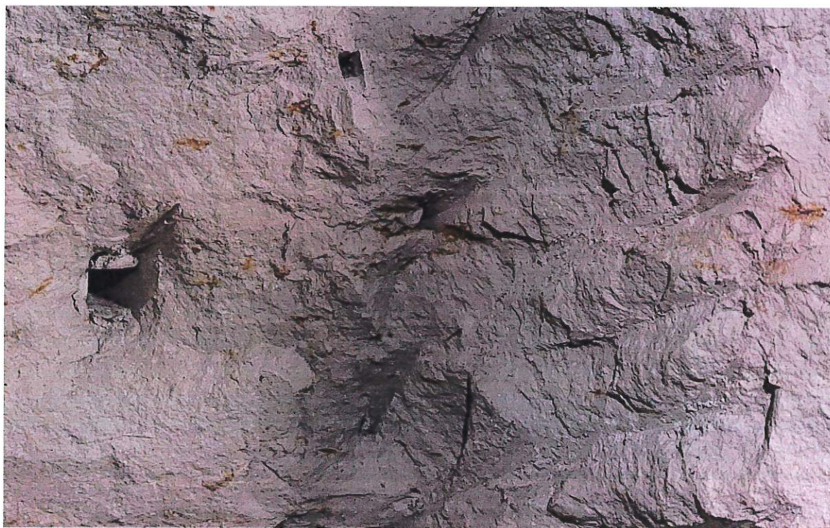
Fot. 29 Ślady wskazujące na technologię drążenia studni i wdzierek.
