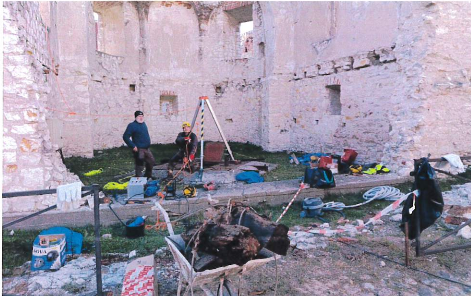
Fot. 1 Instalacja wysokościowa i wyciągnięte ze studni elementy drewnianego pomostu.
