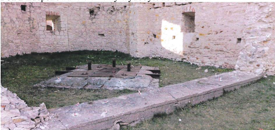
Fot. 3 Stan otoczenia studni po wykonaniu badań.
