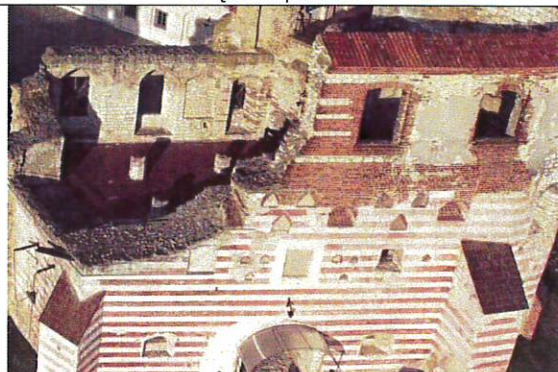
Fot. 16/B. Widok korony muru z góry i od strony zewnętrznej
