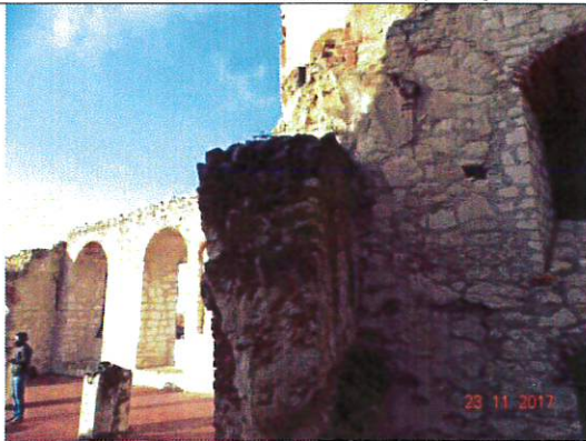
Fot. 7/A2. Widok muru od strony wnętrza
