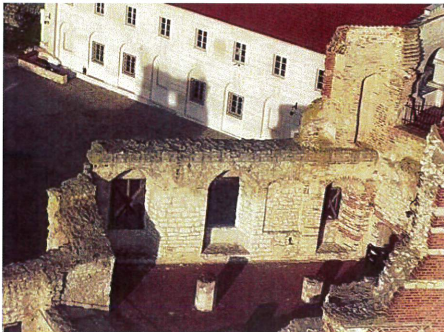
Fot. 41 Sekcja C , widoczna korona murów pokryta kwarcytem.
