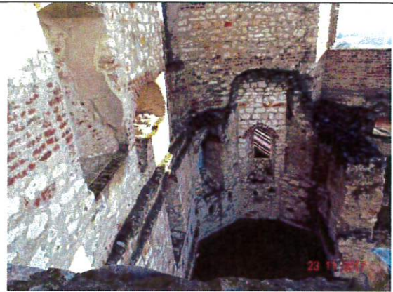
Fot. 6/A2. Widok muru od strony wnętrza
