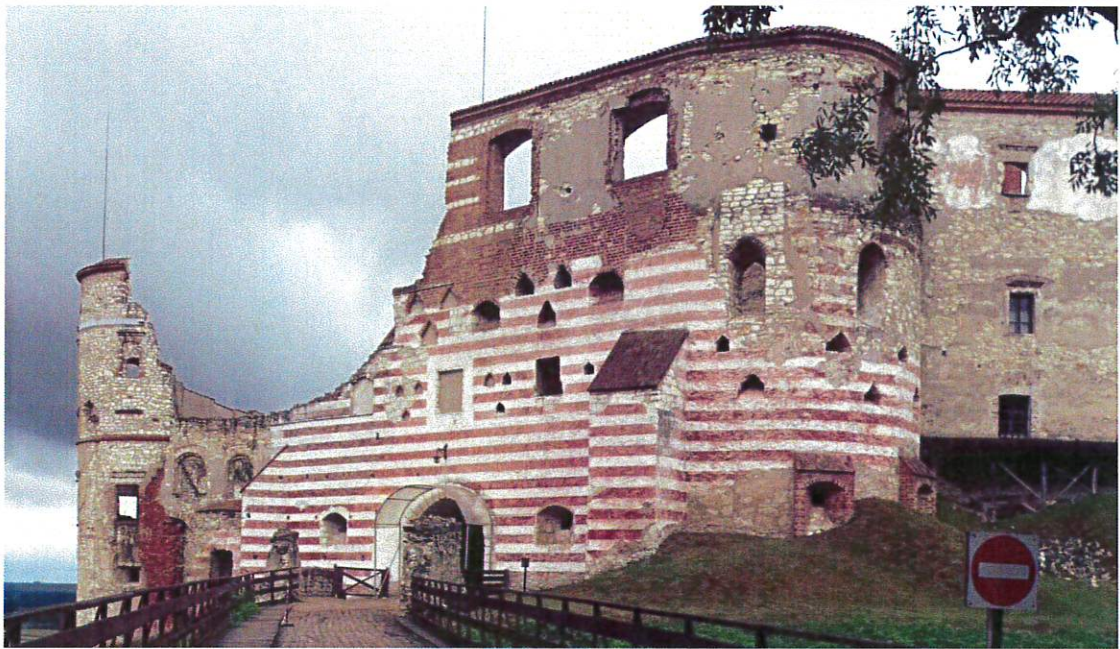
Fot. 3 Widok od strony południowo - wschodniej
