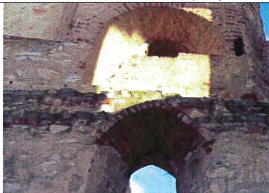
Fot. 9/A2. Widok muru z przemurowaniami kwarcytem
