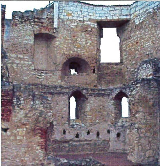
Fot. 5/A2. Widok muru od strony wnętrza
