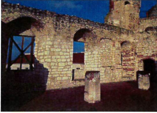
Fot. 19/C. Widok muru od strony wewnętrznej - część od północy
