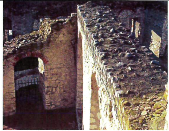
Fot. 22/C. Widok korony muru zabezpieczonej nadmurowaniem kwarcytowym.
