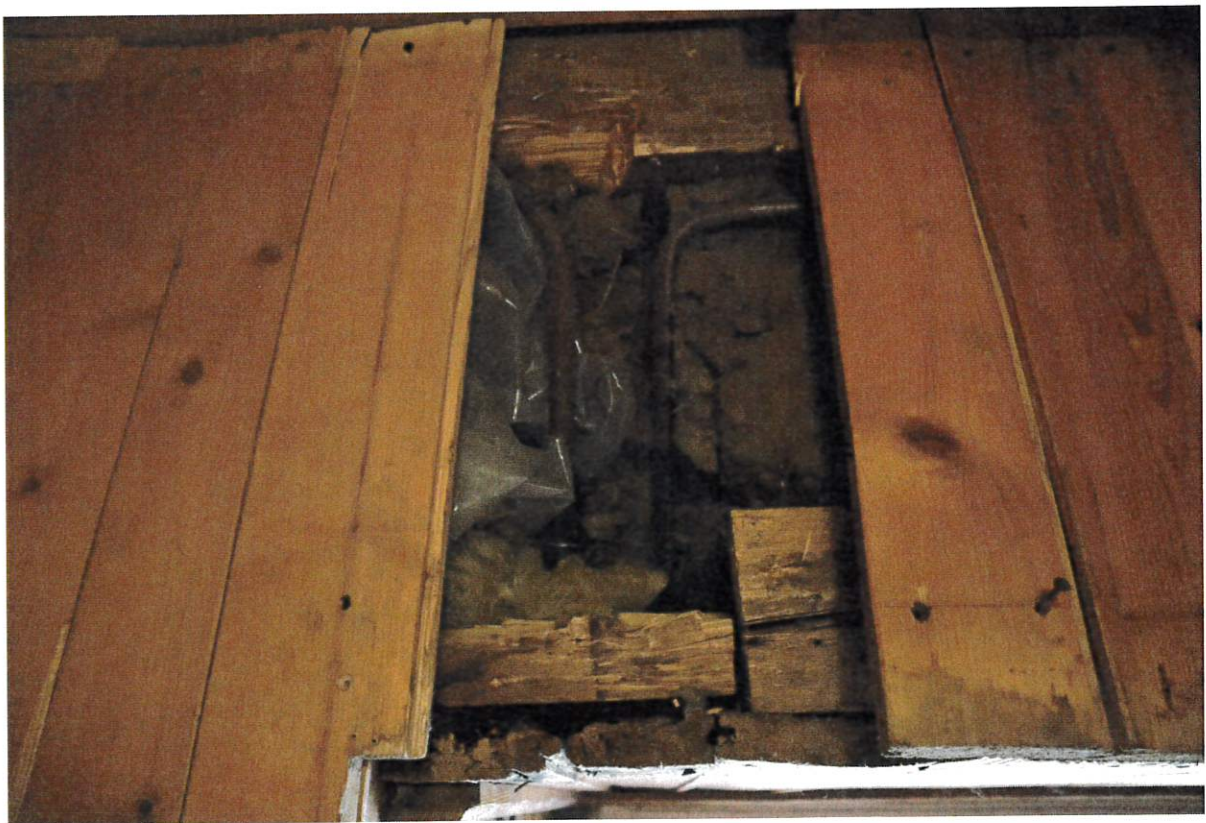
Opis: wykonana metoda odkrywkowa, nieprawidłowe ułożenie wełny oraz nieodpowiedni materiał cieplny
