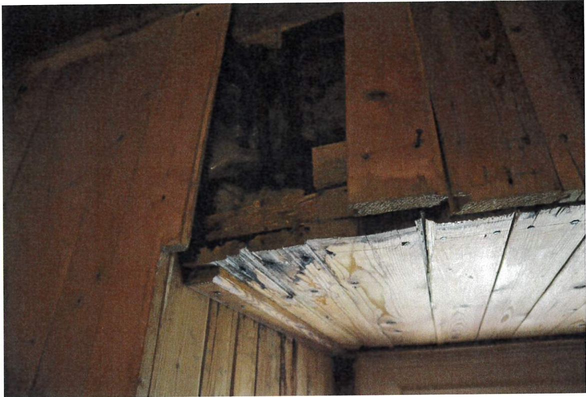
Opis: wykonana metoda odkrywkowa, nieprawidłowe ułożenie wełny oraz nieodpowiedni materiał cieplny
