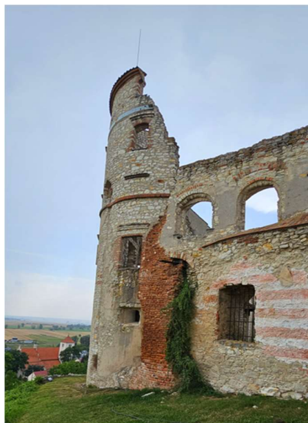
Fotografia 36 Widok na mur od strony zewnętrznej.
