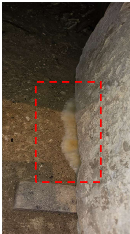
Fotografia 16 Widok na bytowanie strocza domowego – posadzka w lapidarium.
