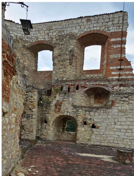
Fotografia 35 Widok na mur od strony wewnętrznej.
