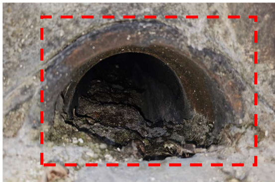
Fotografia 13 Nagromadzone zanieczyszczenia w jednym z wpustów – Sala Rycerska.
