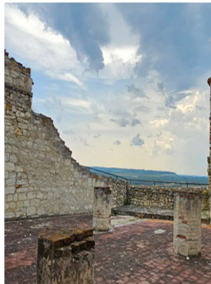
Fotografia 34 Widok na mur od części południowej.
