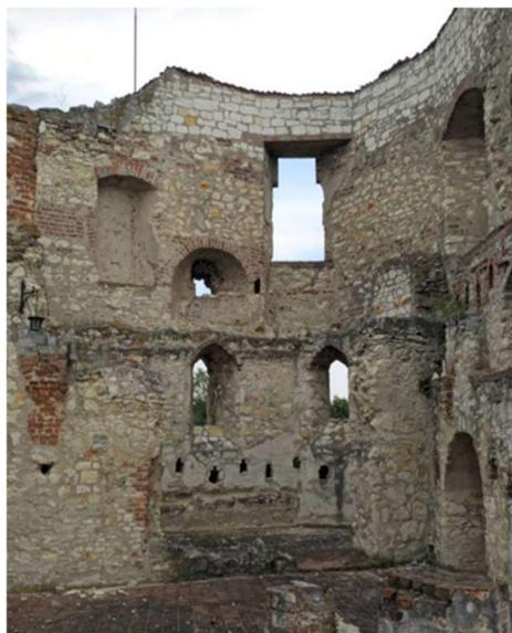
Fotografia 29 Widok na mur od strony wewnętrznej.
