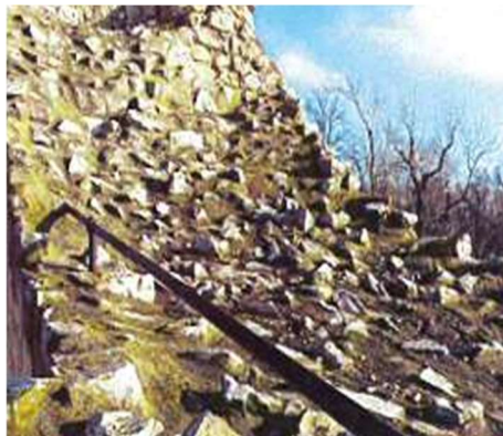
Fotografia 37 Korona muru zabezpieczona kwarcytem. Powierzchnia porażona glonami i porostami. Źródło: [20]
