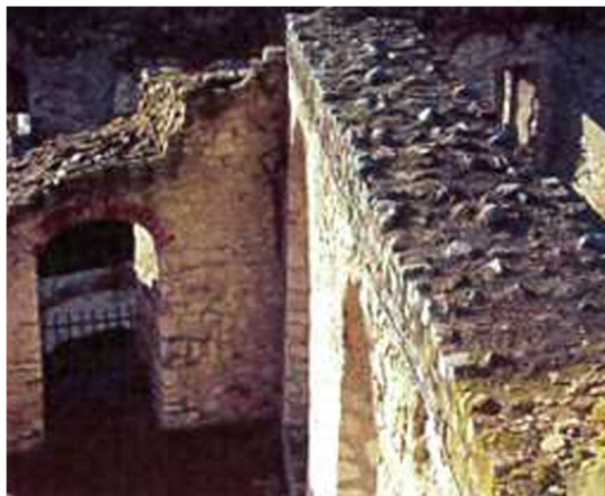
Fotografia 38 Widok korony muru zabezpieczonej nadmurowaniem kwarcytowym. Źródło: [20]
