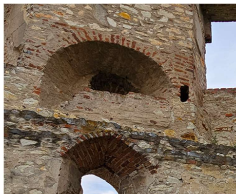
Fotografia 32 Widok na mur z przemurowaniami kwarcytem.
