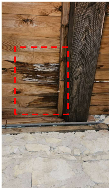
Fotografia 15 Na drewnianej powierzchni spodu stropu lapidarium (-1) występuje powłocznik gładki.
