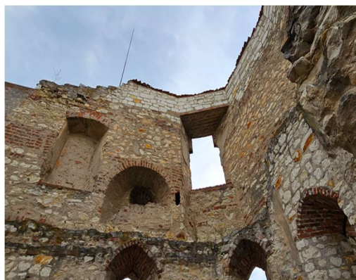
Fotografia 31 Widok na mur od strony wewnętrznej.
